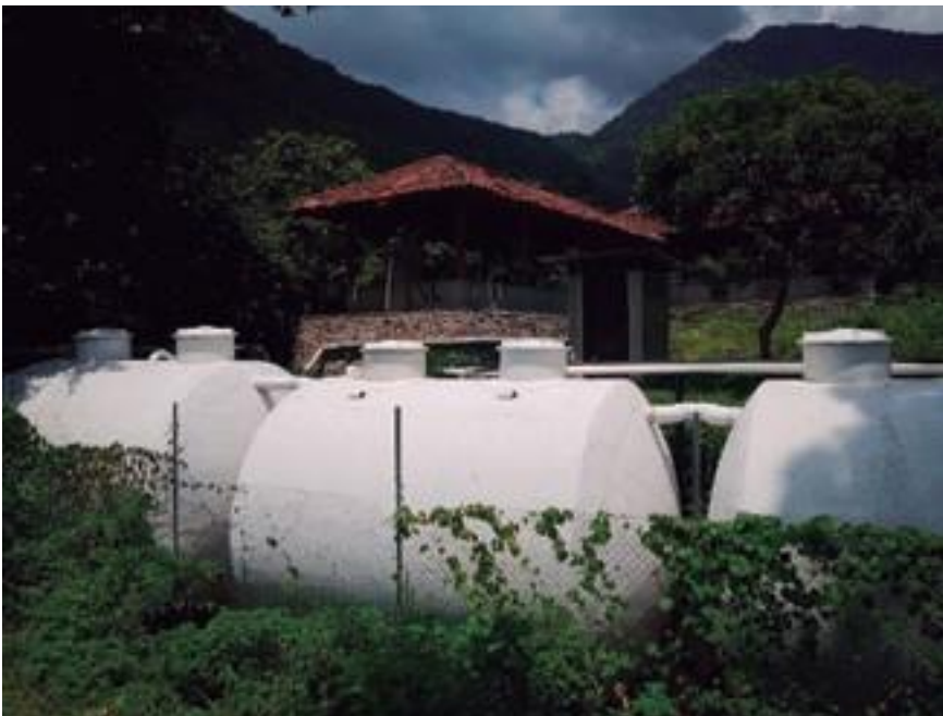
Reparaciones Pilas Públicas Tzununá
